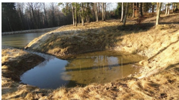
Zatoka napęlniana tylko przy większych stanach wody w zbiorniku. Źródło: Archiwum CKPŚ.
