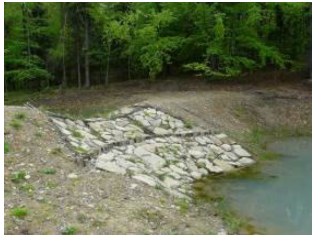
Przelewy górne w zbiornikach w N-ctwie Bielsko
