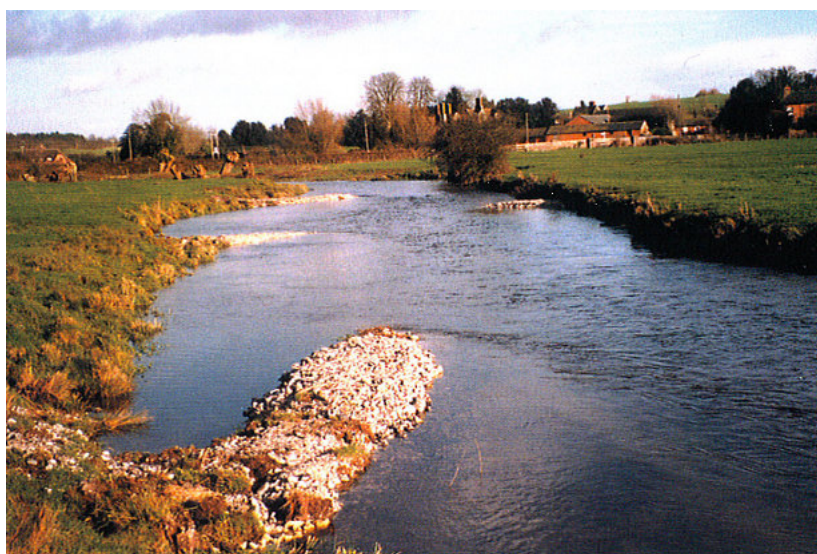
Fot. 4. Ochrona brzegów rzeki wyłącznie przez wykonanie głowic ostróg (Przyjazne naturze kształtowanie rzek i potoków 2006).
