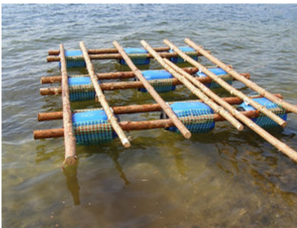
Ptasia wyspa w Lednicy (konstrukcja) - źródło: http://old.zpkww.pl
