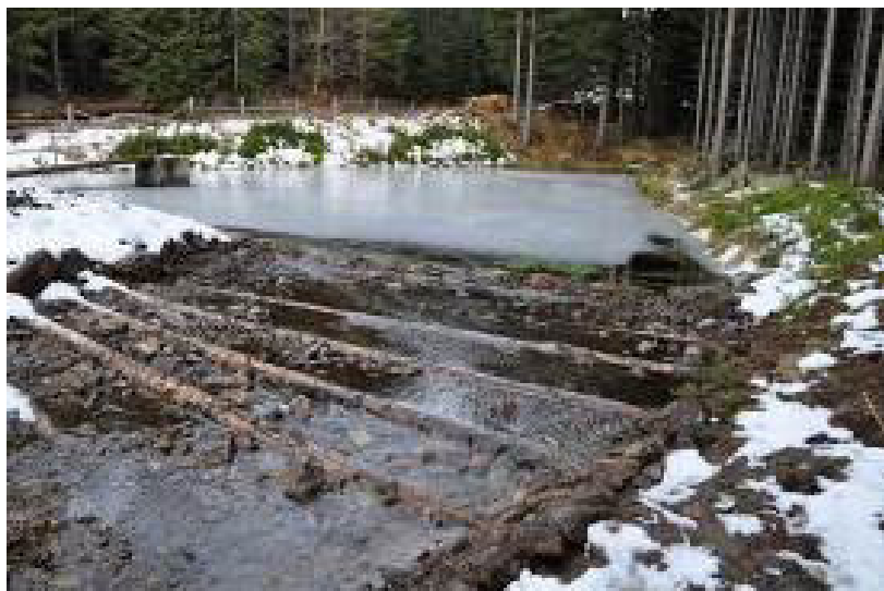
Przelewy górne w zbiornikach w N-ctwie Bielsko
