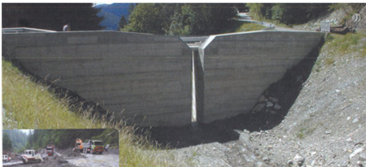
Źródło: Jahresbericht 2002, Forsttechnischer Dienst tur Wildbach – und Lawinenverbauung.
