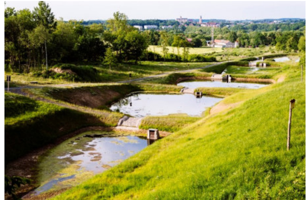
Zbiorniki kaskadowe w Nadleśnictwie Prudnik. Źródło: Archiwum CKPŚ.
